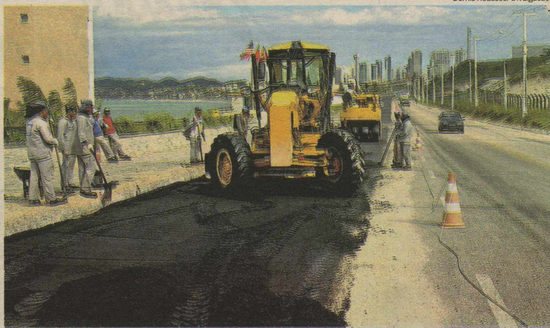
Trabalhadores atuam nos serviços, que buscam criar pistas mais amplas e seguras na avenida que concentra hotéis
