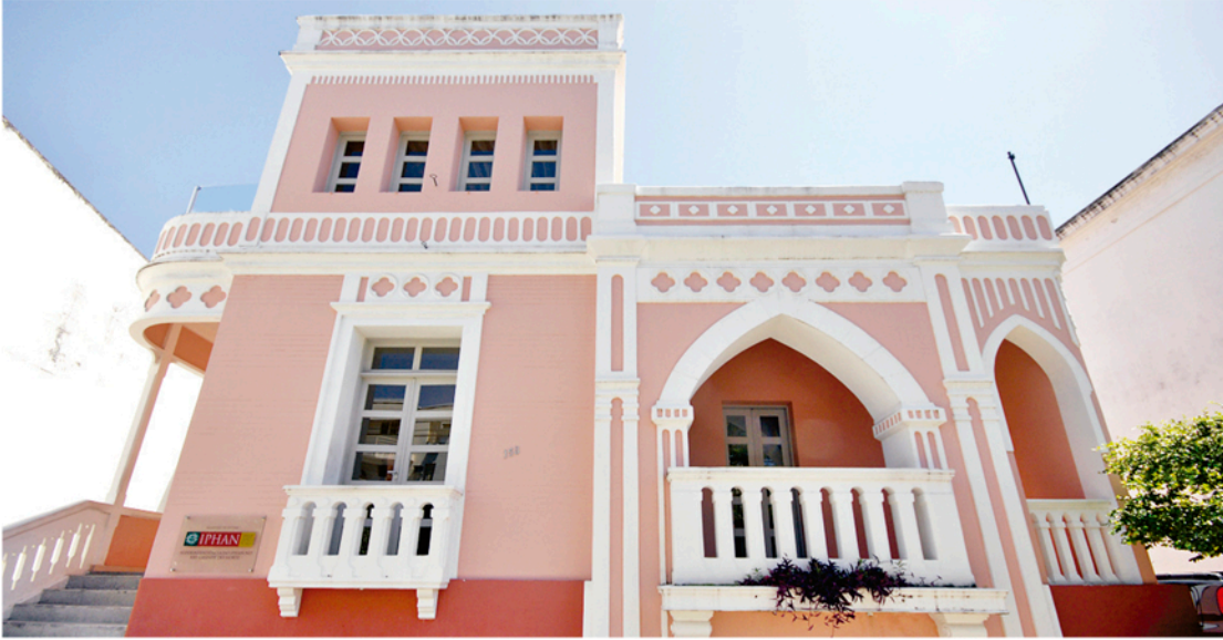
► Prédio do Instituto do Patrimônio Histórico e Artístico da União, Cidade Alta: reformado
