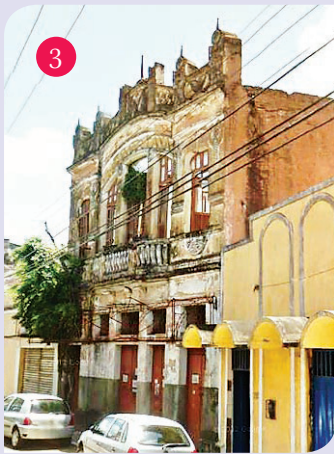
► Prédio na Rua Dr. Barata
