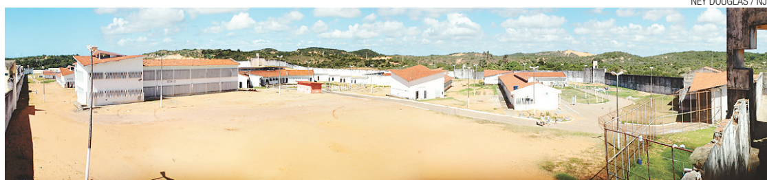
► Penitenciária de Alcaçuz: sete ocorrências de fugas somente no primeiro semstre do ano passado
