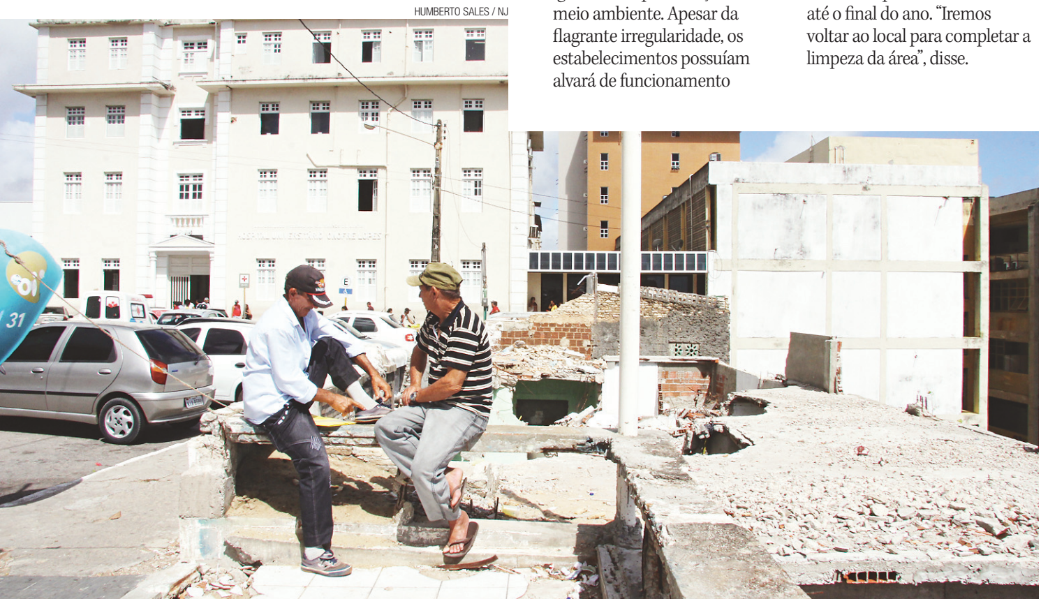
► Conclusão da retirada das estruturas das cigarreiras na avenida Getúlio Vargas deverá ser efetuada até o final do ano
