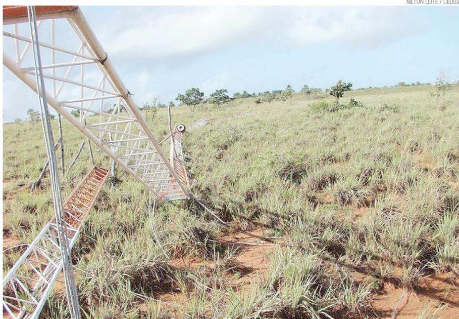
▶ A torre derrubada tinha cem metros e servia para medir a velocidade do vento
